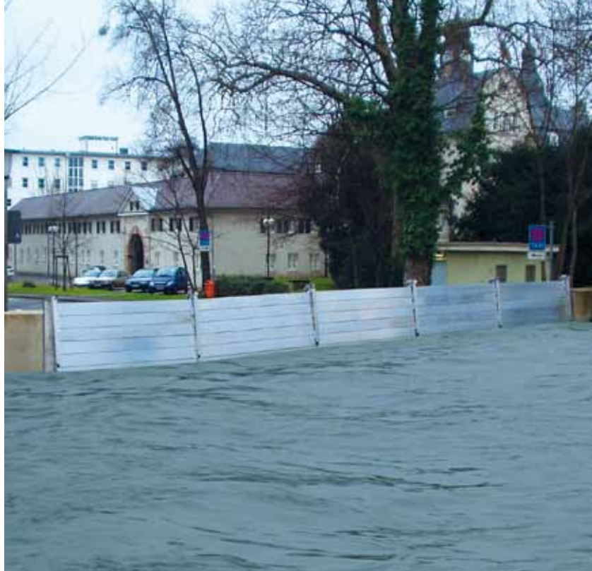
Mobiler Hochwasserschutz mit Dambalken
