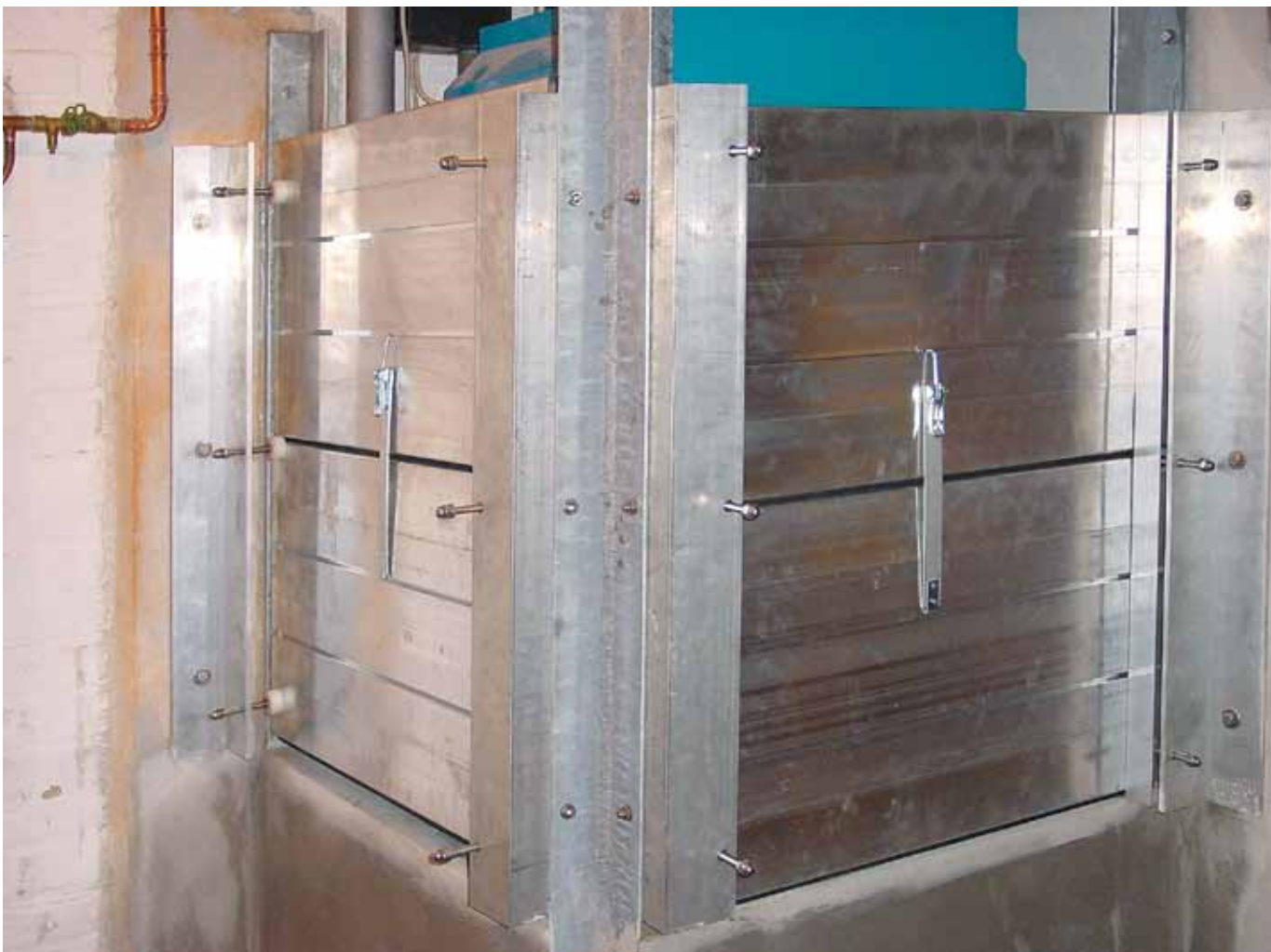
Sicherung eines Heizbrenners
